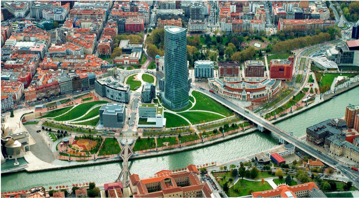
Ilustración 27 - El sector de Abandoibarra en la actualidad.
