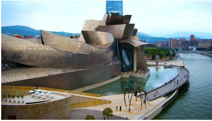
Ilustración 19 – Pasarela peatonal y estanque
