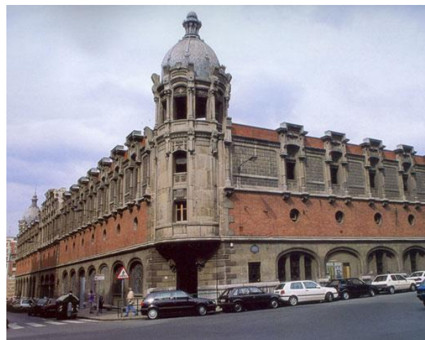
Ilustración 17 - La Alhóndiga Municipal previa a su restauración.
