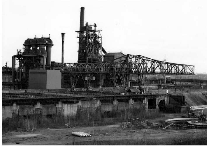
Ilustración 42 - Complejo industrial abandonado hacia 1991
