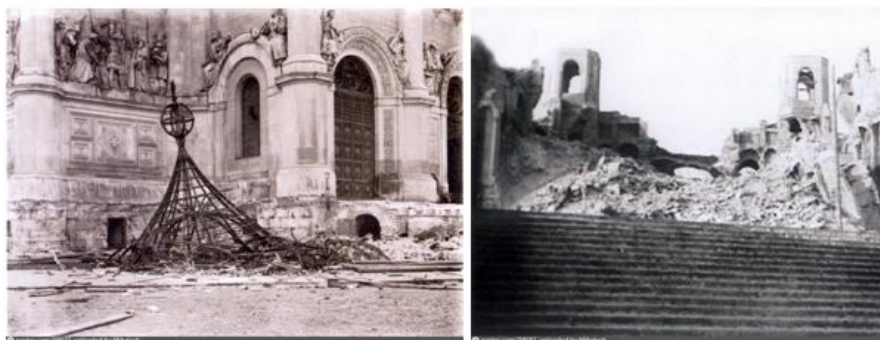
Destrucción de la cúpula y los muros de la Catedral
