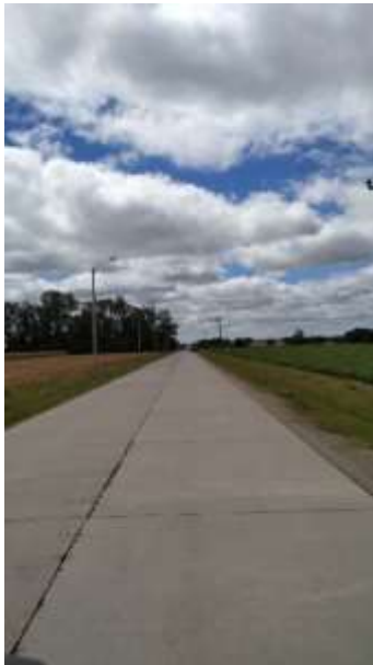
Ilustración 53 - Locación para pruebas del alcance del radio enlace
